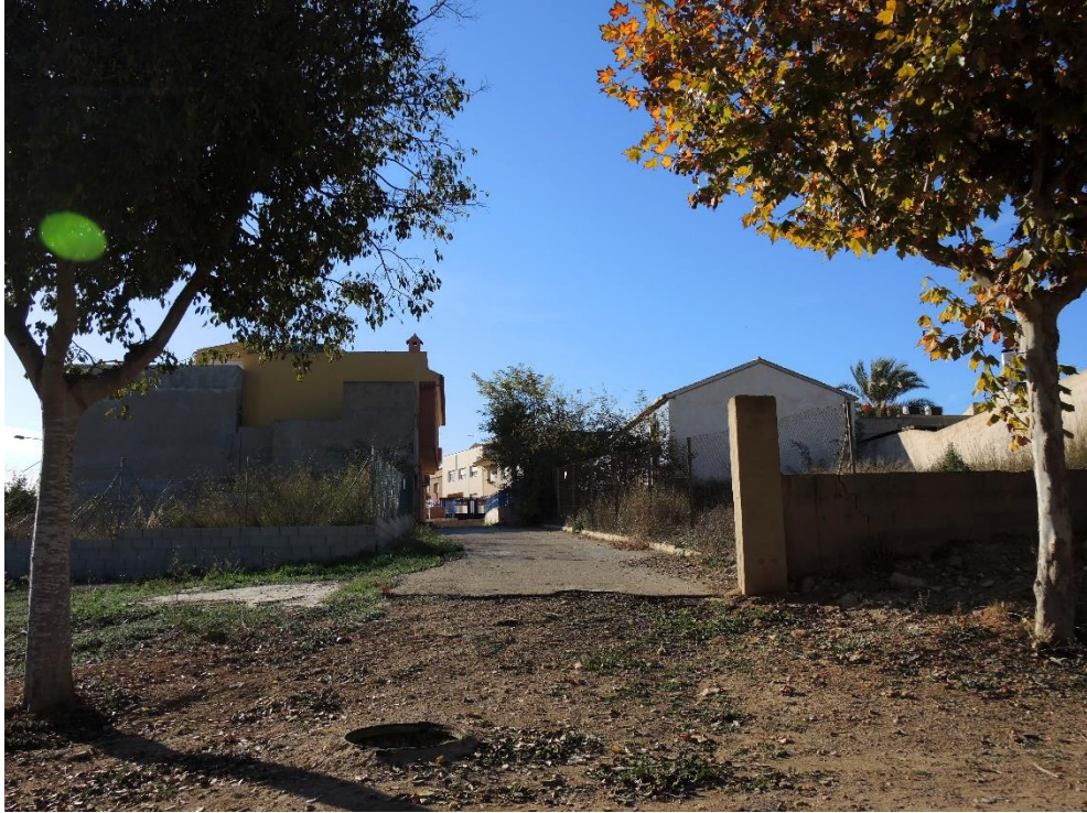
Fotografía 1. Vista panorámica general, hacia el oeste, de la calle Miguel Cervantes.
